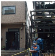
隣家火災 写真左:レスコハウス
